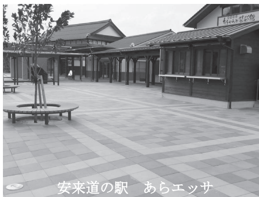
写真 3 インターロッキングブロック適用事例
