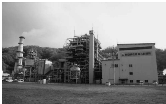
写真1 釜石火力発電所全景
