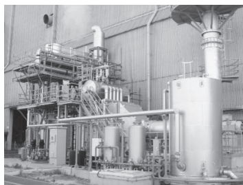
写真2 (東予)排熱回収ボイラー
