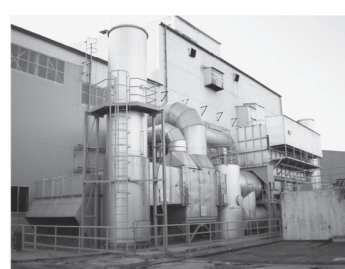
写真3 (市川)蓄熱燃焼式脱臭炉
