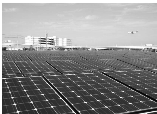
写真1 川崎大規模太陽光発電所 1)
