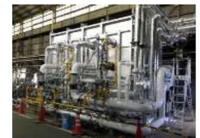
DINCS試験炉（滝春テクノセンター内）
