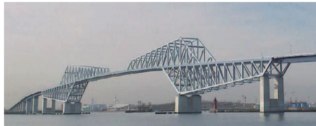
東京ゲートブリッジ(トラス橋) *6-4)
