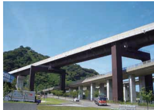
北陸新幹線架橋(耐候性鋼) *6-2)
