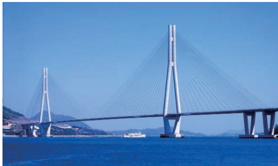
多々羅大橋(斜張橋) *6-3)
