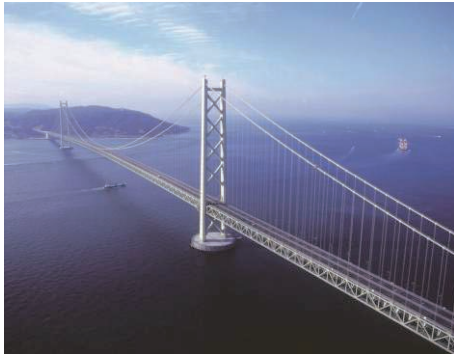
明石海峡大橋(吊橋) *6-1)
