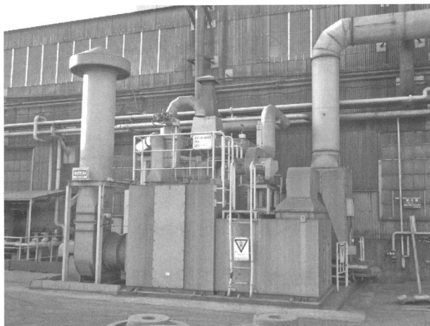
写真1 車輪塗装ラインVOC処理装置 (交通産機品カンパニー) 設置対象 : 車輪塗装ライン 排風量 : 300Nm 3 /min VOC濃度 : 最大濃度 1,100ppm : 平均濃度 700ppm : 処理後濃度 105ppm VOC除去率 : 85%以上
