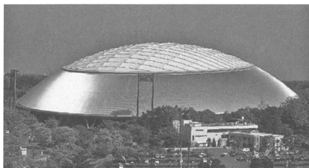
写真1 球場屋根におけるSUS445J1の施工例
