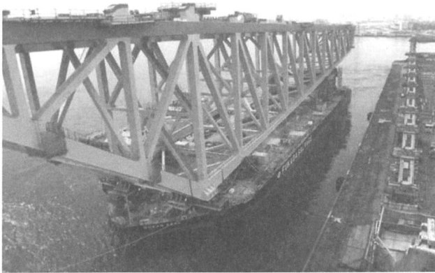
写真 11 台船に大ブロック搭載完了
