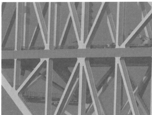
図 2 トラス橋格点部（左：東京ゲートブリッジ、右：一般橋）
