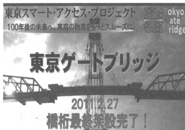
図 6 東京ゲートブリッジ橋桁最終架設完了 (国土交通省 東京港湾事務所HPより)
