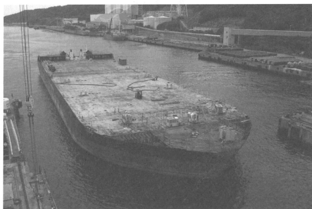
写真 9 台船改造（切断撤去）完了
