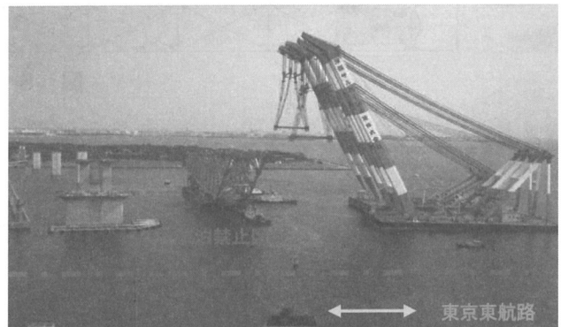
写真 13 海上輸送状況(架設地点入域)
