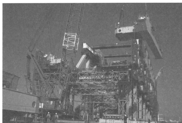
写真3 地組立状況（下弦材地組立）
