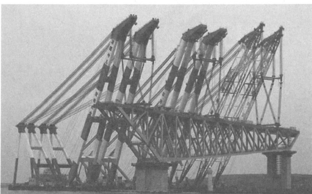
写真 14 大ブロック架設状況
