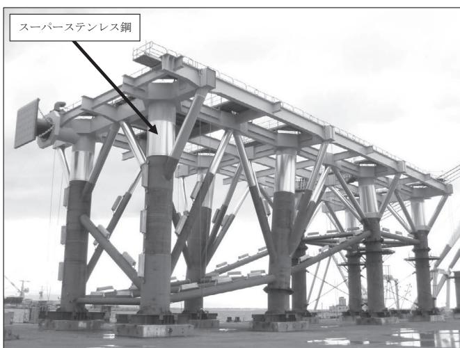
図 2 スーパーステンレス鋼で飛沫部及び干満部をライニングしたジャケット
