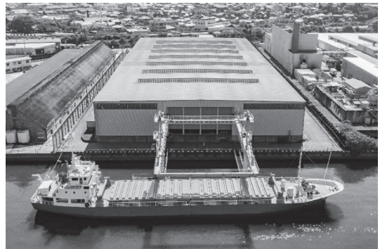
☆衣浦サービスセンター☆ (保管能力：棒鋼9,500t／線材6,600t)
