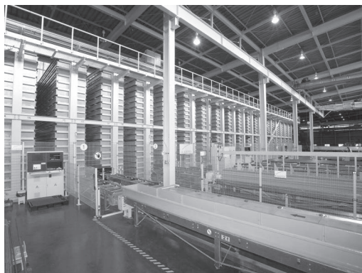
立体自動保管システム (浦安鉄鋼センター内)
