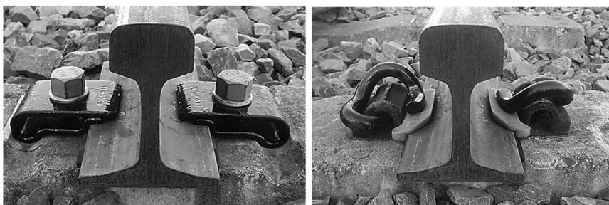
写真1 レール締結装置 (左: 板ばね 右: 線ばね)
