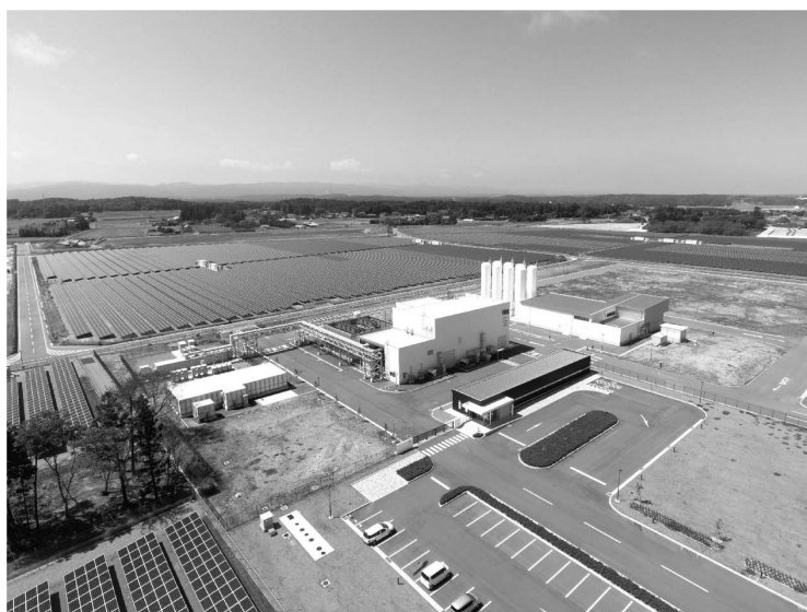
図 2 FH2R全景（写真提供 東芝エネルギーシステムズ）
