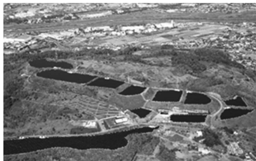
図 1 米倉山太陽光発電所全景
