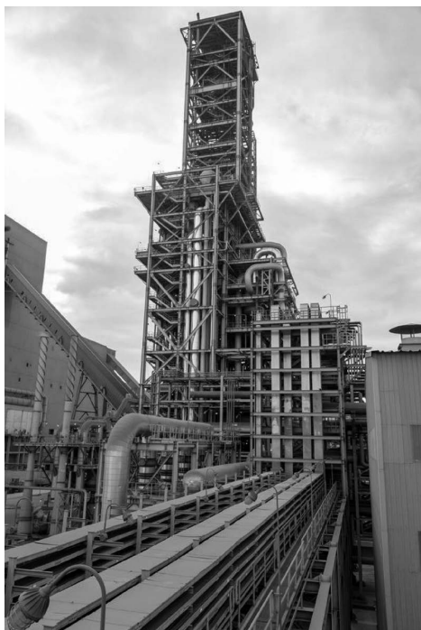
図 2 アルジェリア・オランのトシアリ社の製鉄所に建設された年産250万トンの最新MIDREXプラント
